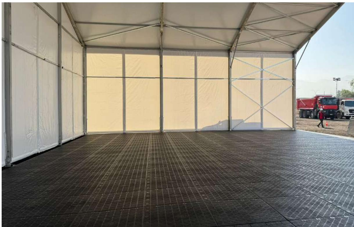
Lonas confeccionadas con membranas de PVC de alta resistencia Black Out de 850gr/m<sup>2</sup> para techos y laterales de 650gr/m<sup>2</sup> con un 14% de translucidez. Todas las lonas son fabricadas y unidas mediante sellado de alta frecuencia garantizando un 100% de impermeabilidad.
